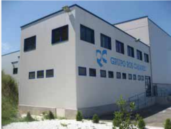
Edificación de Meltec
