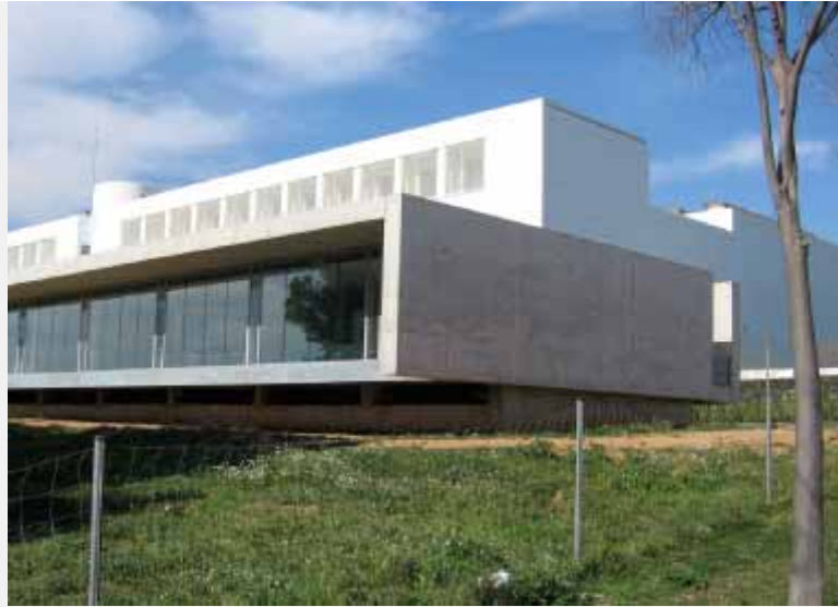
57 viviendas en Campus UPC de Sant Cugat del Valles de Compact Habit
